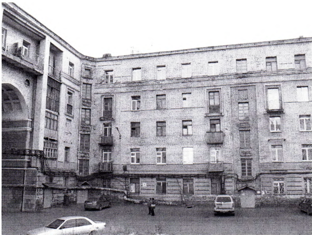
Фото 2. Вид с северной стороны
