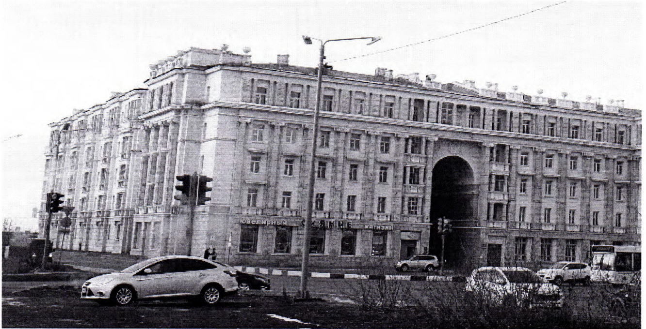
Фото 1. Вид с юго-восточной стороны
