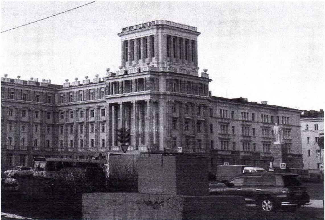
Фото 1. Вид с юго-восточной стороны
