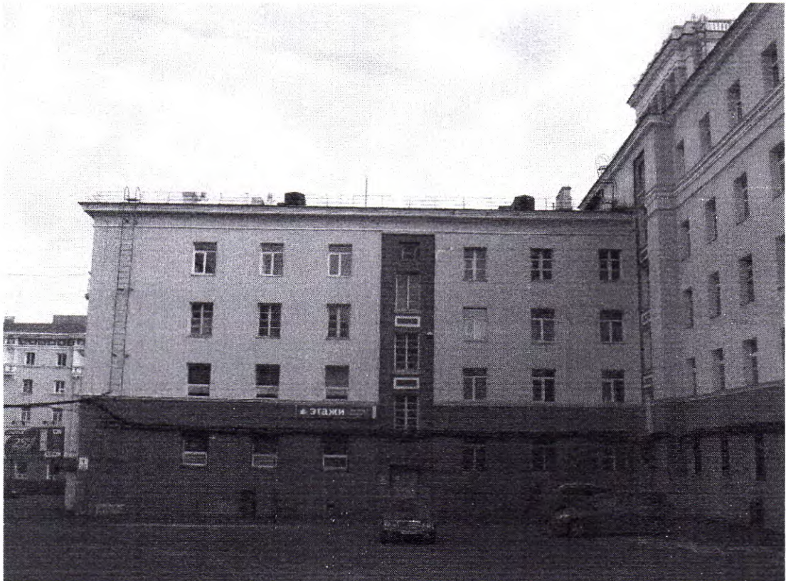
Фото 2. Фрагмент западного фасада
