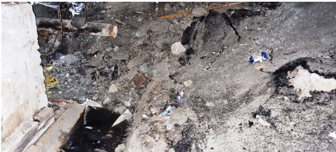
Фото №4. Подполье в осях Г/Д-3/4.
