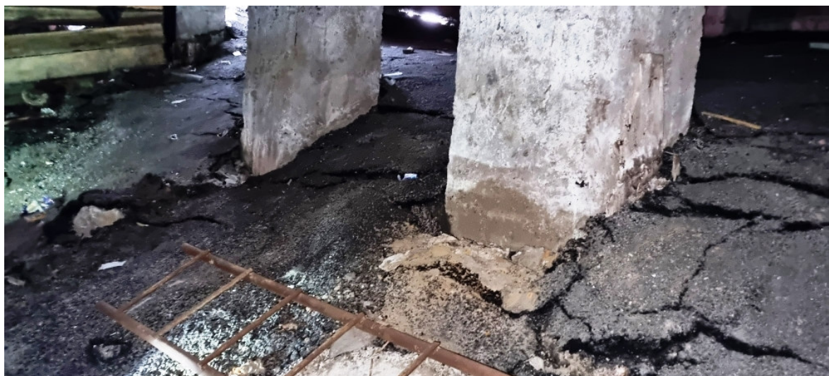
Фото №2. Подполье в осях Б/Г-3/6.
