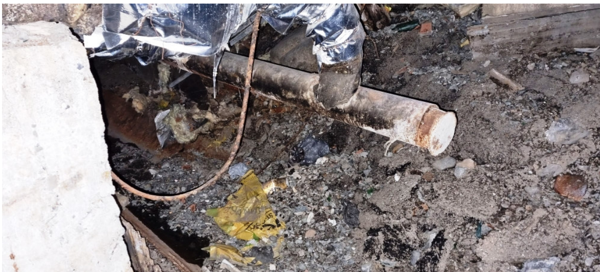
Фото №5. Подполье в осях Г/Ж-3/4.
