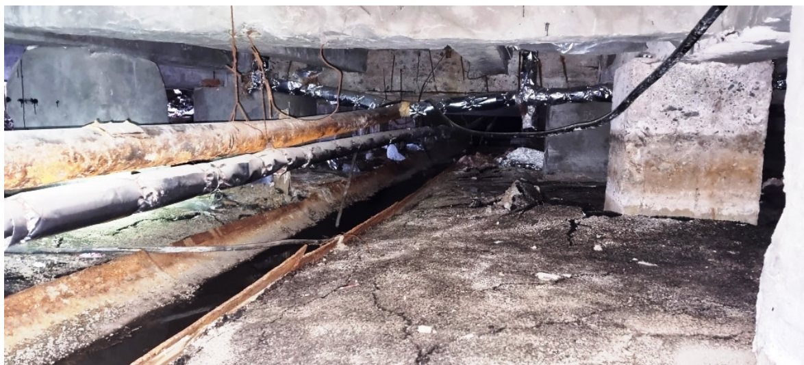
Фото №1. Подполье в осях И/К-2/5.
