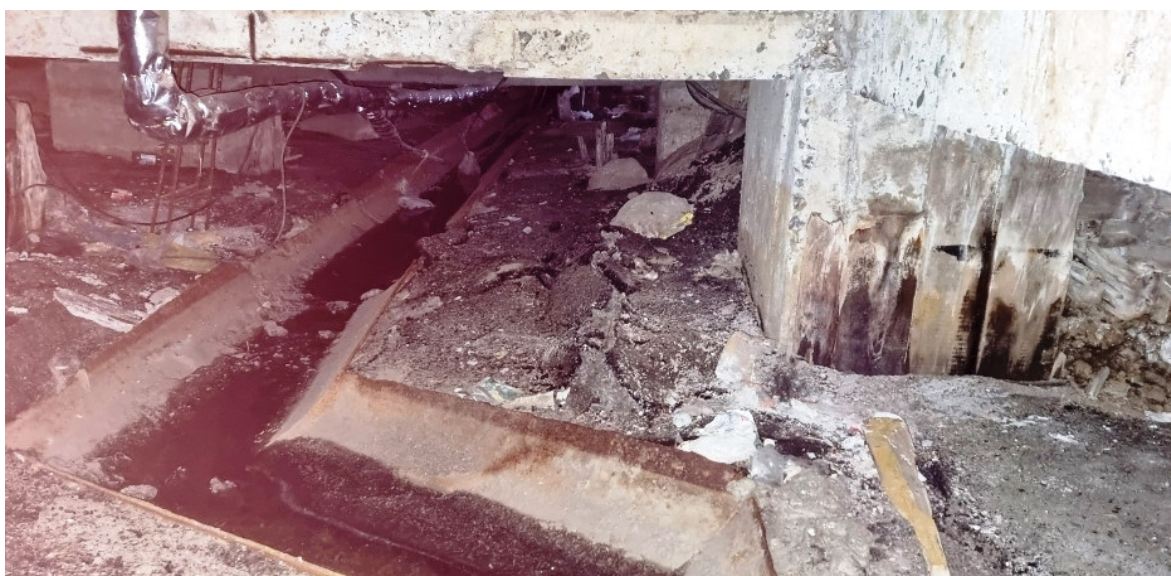
Фото №3. Подполье в осях В/Д-3/6.
