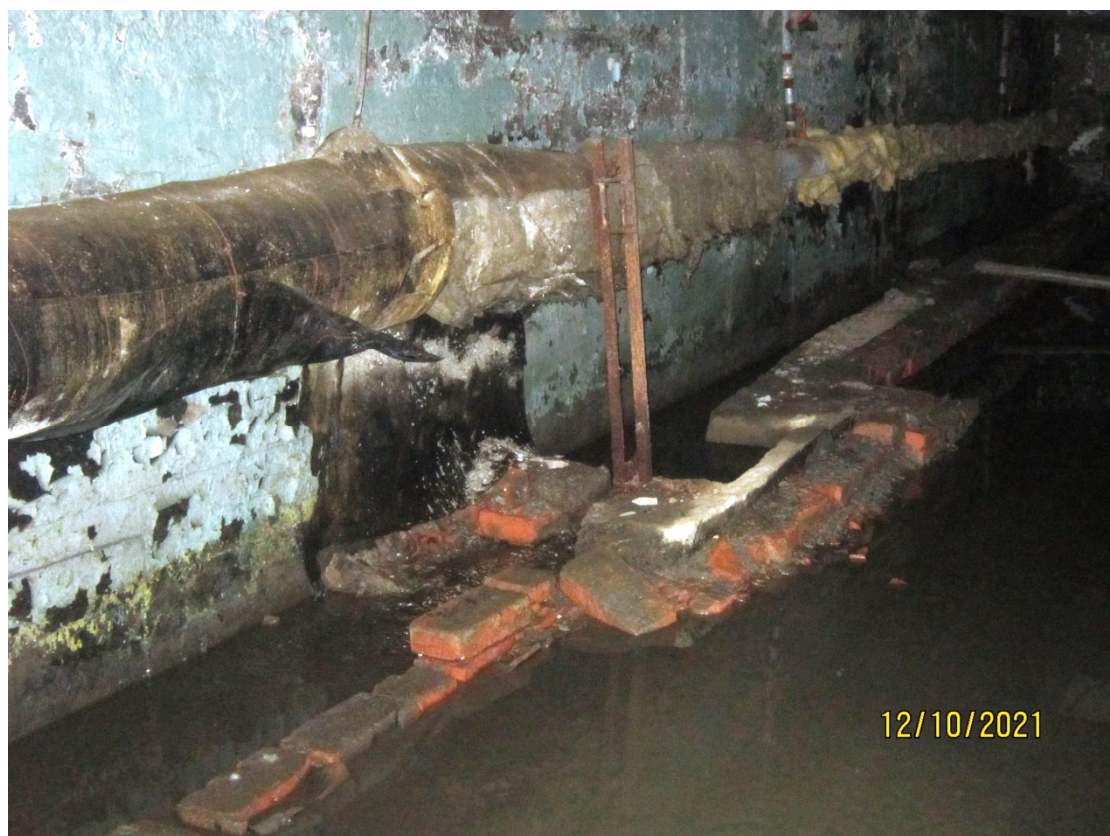
Фото №2. Подвальные помещения в осях А/Б-12/14.
