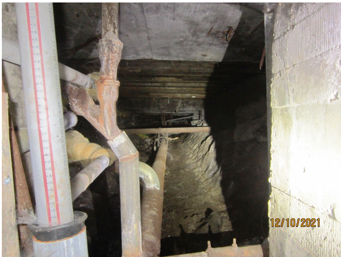
Фото №1. Подполье в осях А/Г-9/15.
